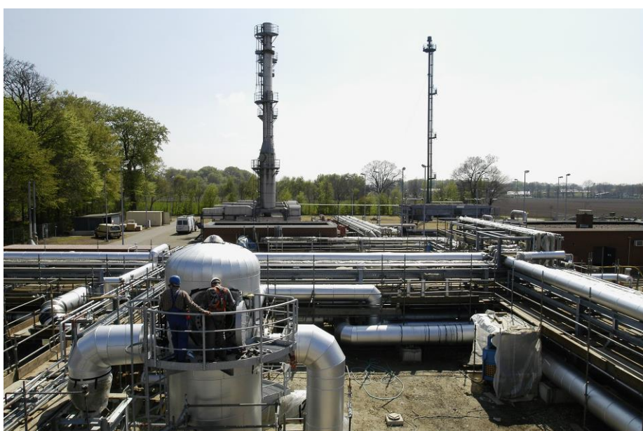
Arbeiten an der Verdichterstation Visbek in Südoldenburg © ExxonMobil
